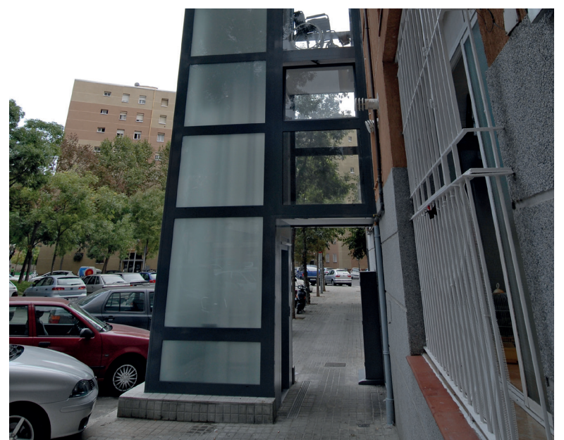
L'ascensorista aconsellarà en relació a la tipologia de l'aparell més adequat a instal·lar i valorarà l'impacte de les obres auxiliars
