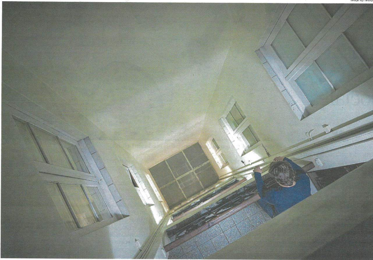
Un vecino mira por el hueco que ocupará el ascensor pendiente de instalar en una finca del Eixample, el viernes pasado.
