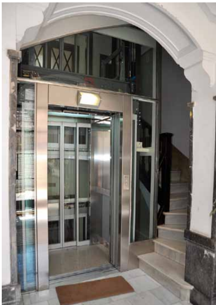
Ascensor rehabilitado en vestíbulo
