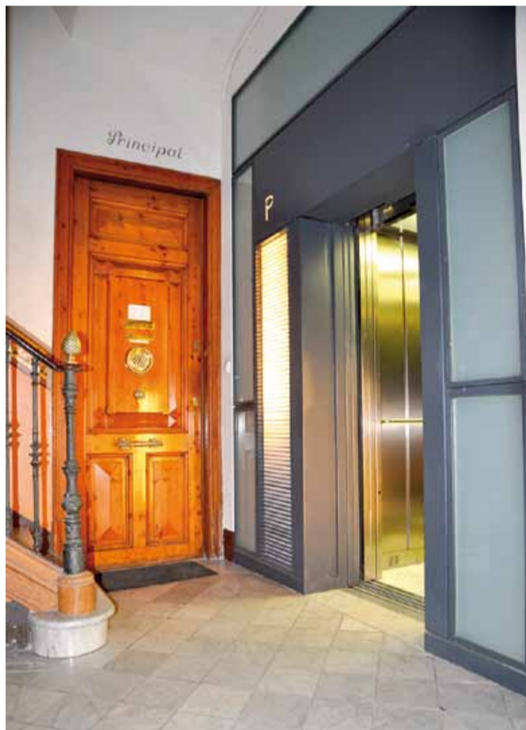
Instalación de ascensor en edificio rehabilitado
