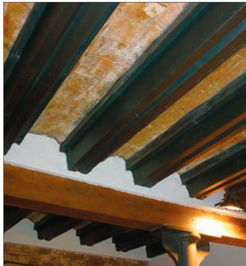
Techo de un edificio reforzado con las viguetas Nou Bau.
