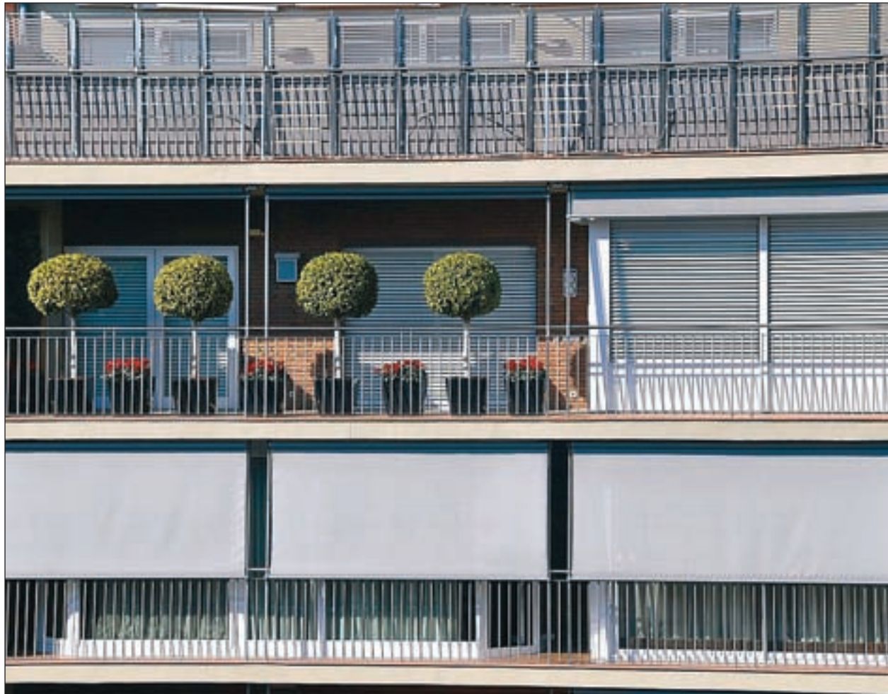
Rehabilitación de un edificio de viviendas en Barcelona seleccionada en los premios Catalunya Construcció 2011.
