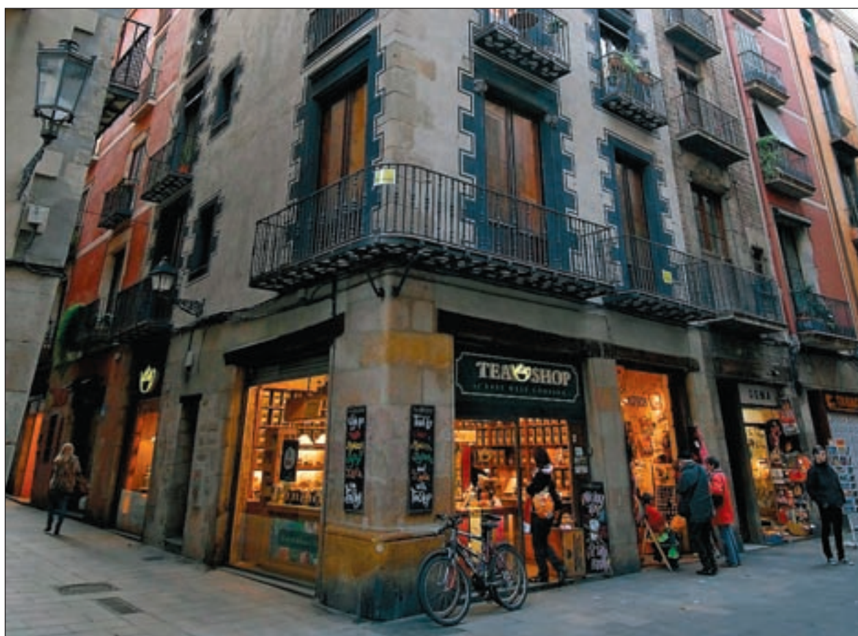
Fachada rehabilitada de la calle de los Sombrerers, 27, en Barcelona.
